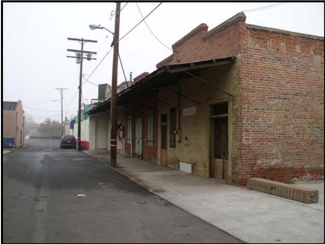
UM – Apparent Unreinforced Masonry
